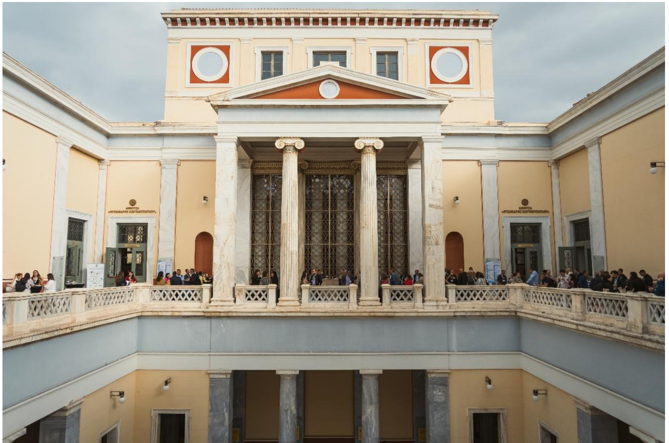
Άποψη του εξωτερικού της Αίθουσας Κατακλζόγλου
